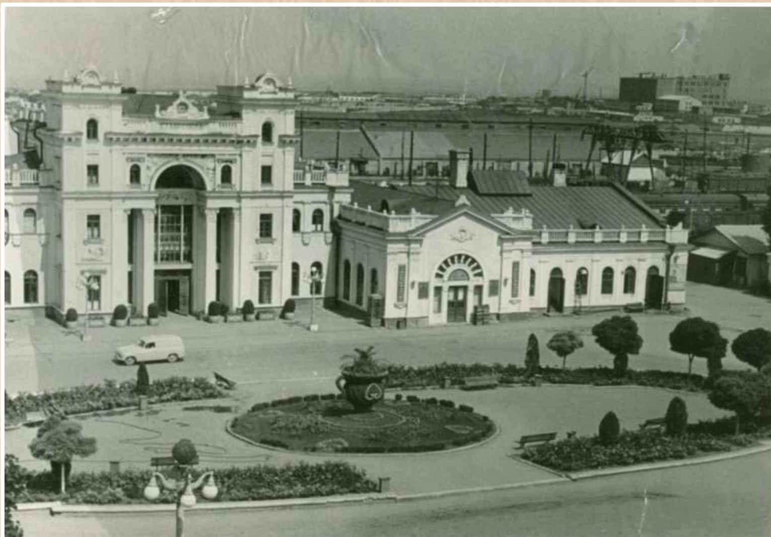
Железнодорожный вокзал (памятник истории и культуры федерального значения). 1960 год (Ф. 70, оп. 1, д. 6 л. 23)
